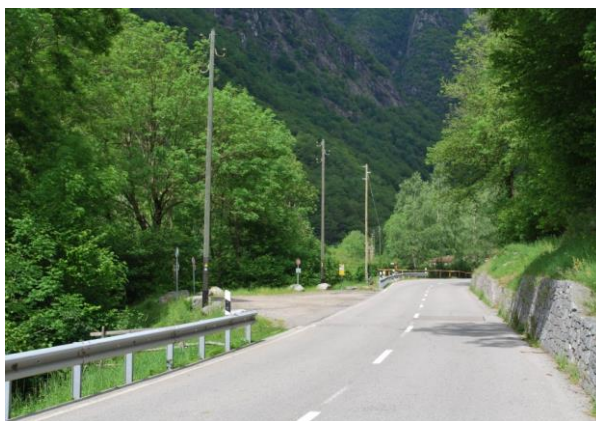
Kurzzeitparkplatz - Lavertezzo Wendeplatz
